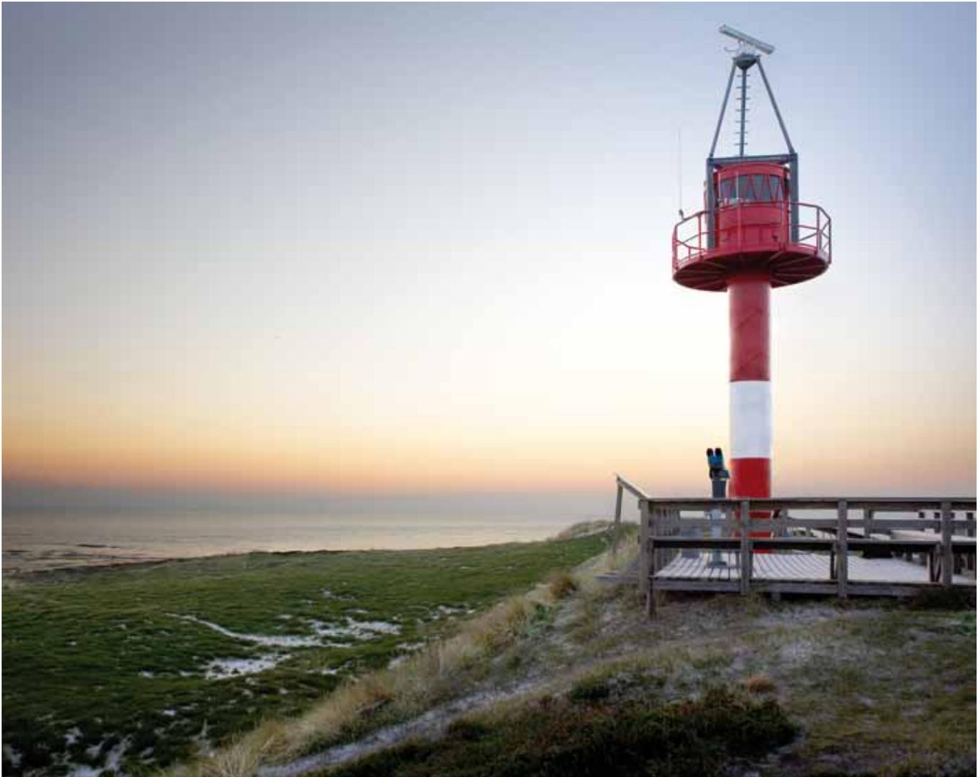
[Radar auf dem Hörnum Leuchtturm](#): Aus den Radar-Beobachtungen von Strömung und Wellen lässt sich der Sandtransport zum Beispiel an der Westküste von Sylt bestimmen.
